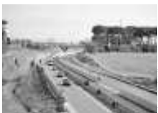
Lavori di adeguamento della variante Aurelia
